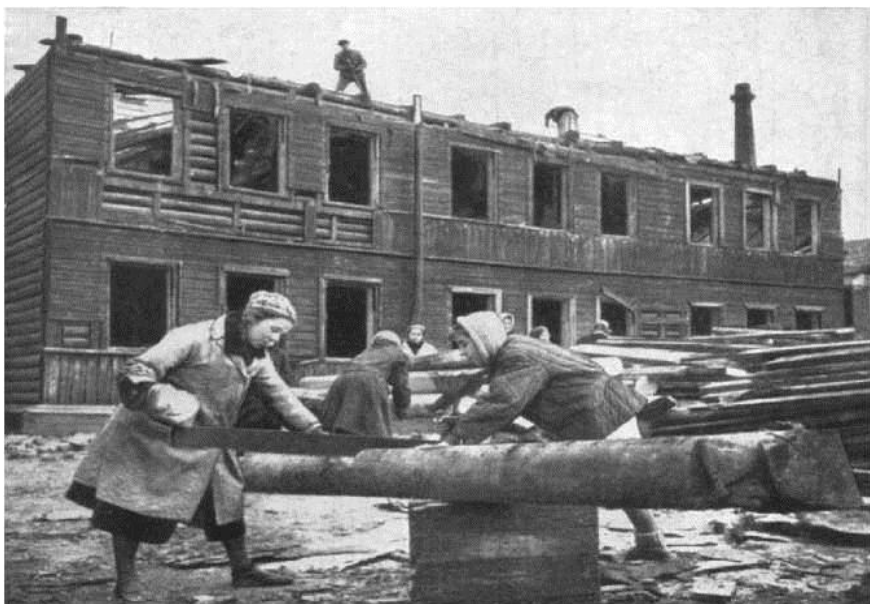
Разборка деревянных зданий на топливо в 1942 г.
